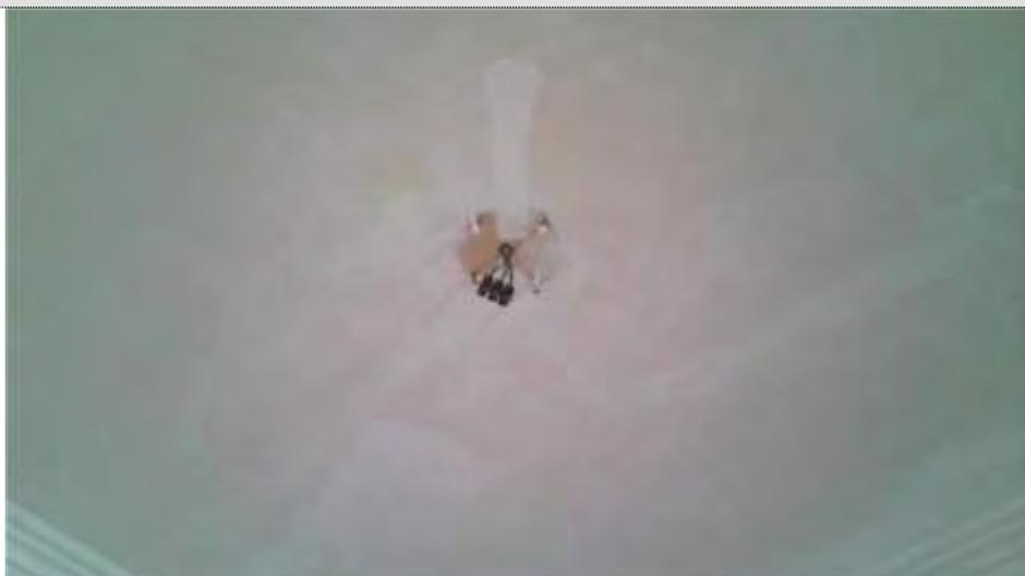
Description : L'installation électrique comporte au moins une CONNEXION avec une partie active nue sous tension accessible.
